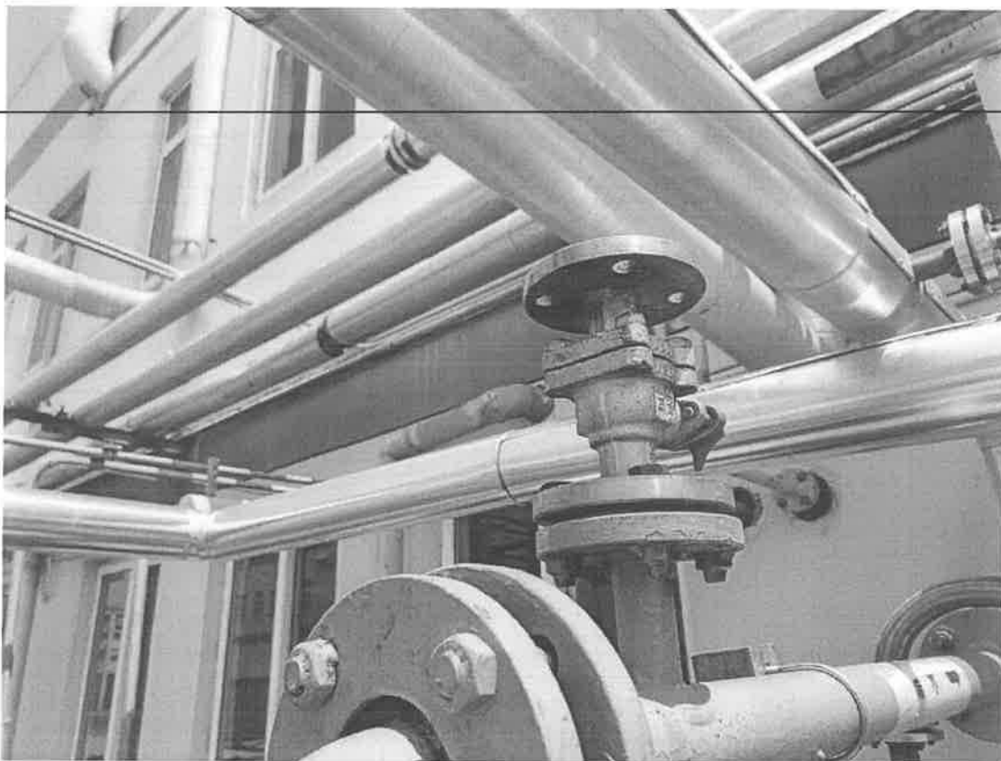
整改后：保泰松车间低浓池 P04410 出口管道阀门进行封盲。
