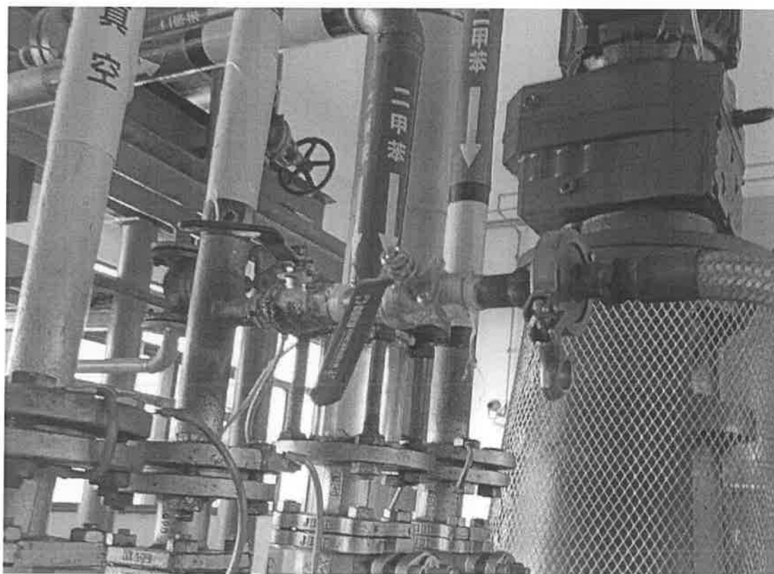
整改后：7 号楼 R03301A 乙醇管道设置双阀。
