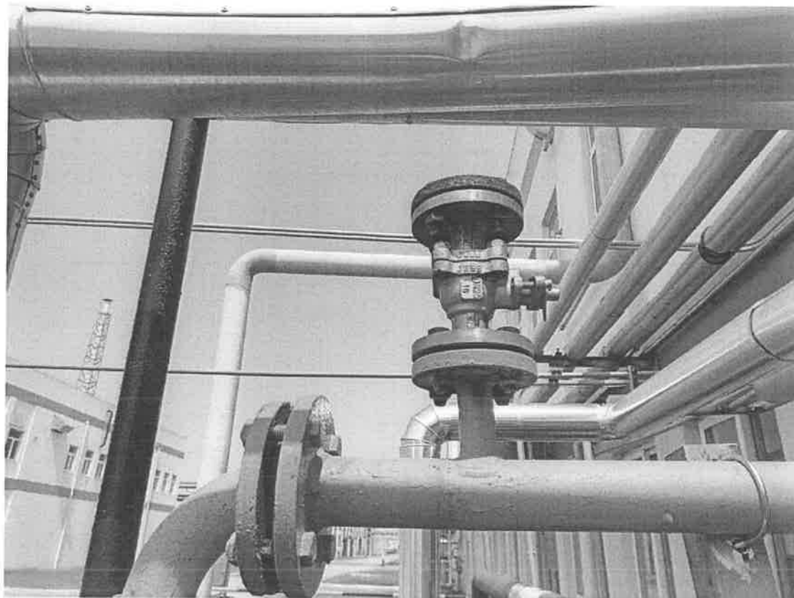
整改后：保泰松车间低浓池 P04410 出口管道阀门进行封盲。
