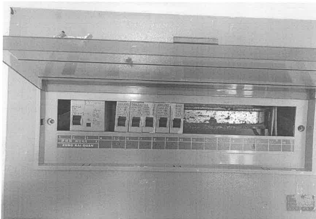
整改后：9 号楼一楼东侧电气开关盒补全标识。
